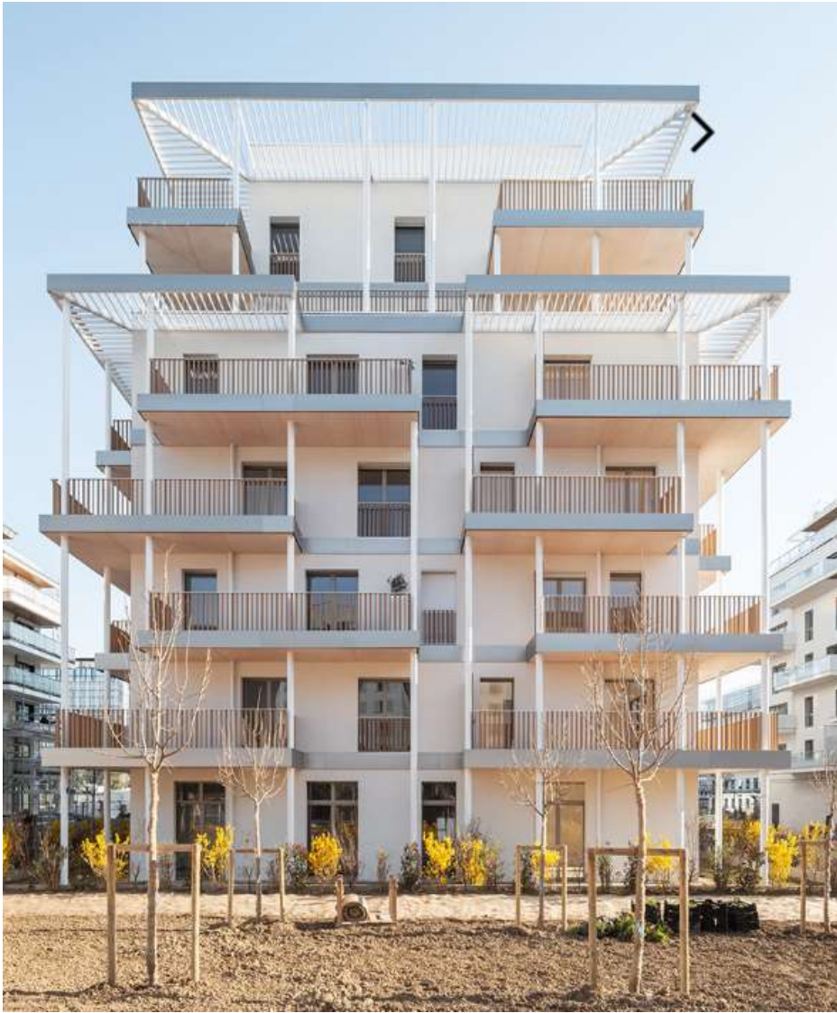
Velizy Morane Saulnier Logements sociaux en structure bois
