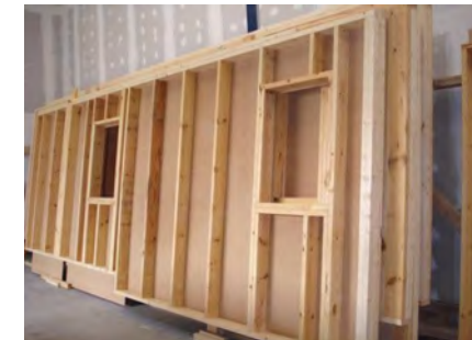
Façades en mur à ossature bois
